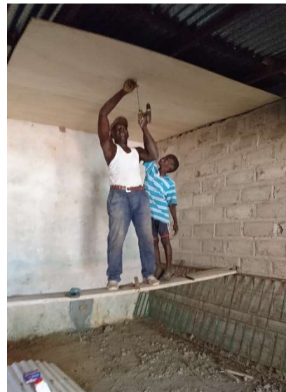
Aanbrengen van het plafond
