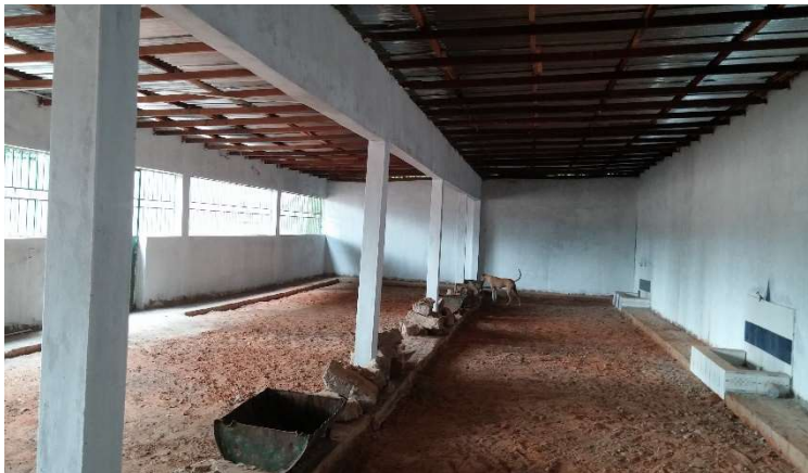
Foto: Het gebouw voor aanvang van de verbouwing
